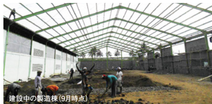
建設中の製造棟(9月時点)
