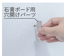
石膏ボード用穴開けパーツで下穴を開けます。
