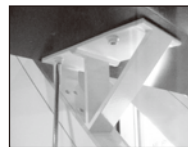
踏板取り付け
