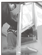
パネルの取り付け
