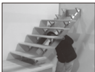
上下取付板本固定
