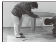
支柱の位置出し
