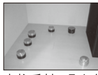
支柱受材の取り付け
