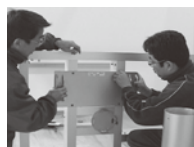
取付板・サポートの取り付け
