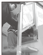
パネルの取り付け
