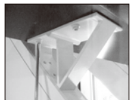
踏板取り付け
