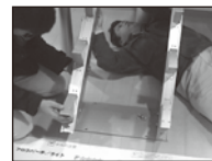
上下取付板本固定
