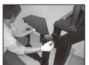
踏板板の取り付け 本固定
