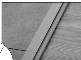
④実部を結合してください。継目からはみ出したコーティング剤はヘラなどを使い、隙間なく塗りのばしてください。
