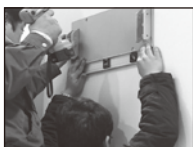
上部・下部取付け板の固定
