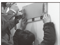
上部取付板仮固定
