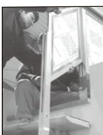
パネルの取り付け
