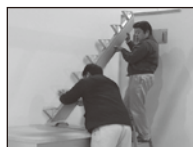
下部取付板仮置き・本体桁取り付け
