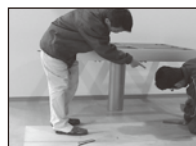
支柱の位置出し
