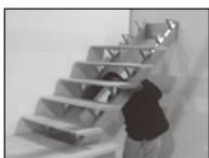
上下取付板本固定
