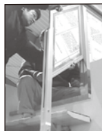
パネルの取り付け
